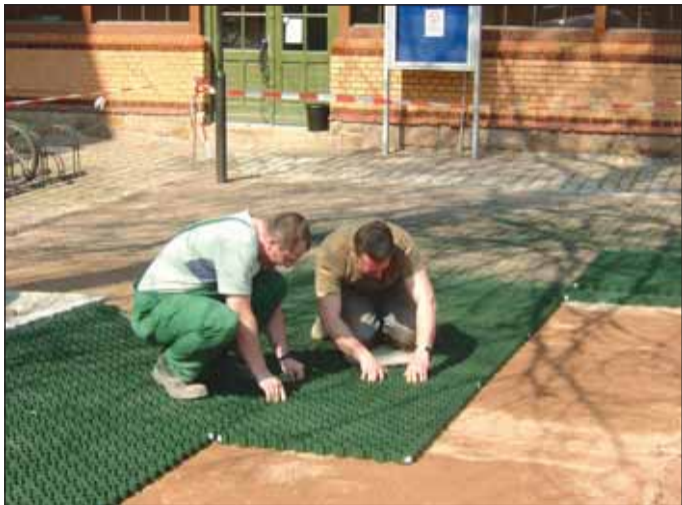
Der Schulhof der Fichteschule vor der Bürkelhalle wird mit Rasengitterplatten ausgelegt.
